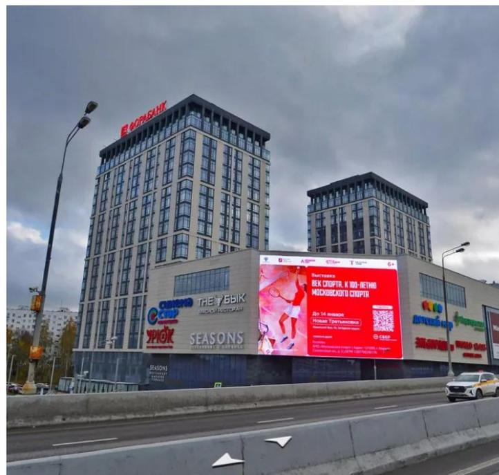
Комплекс состоит из двух 22-этажных башен, объединенных шестиэтажной торговой галереей. Башни возведены по монолитной технологии, фасады облицованы панелями из закаленных витражей, алюминиевых панелей и керамических плит. На первых этажах спроектированы просторные лобби с дизайнерской отделкой, стойкой ресепшен для встречи гостей и зоной отдыха с эко-камином. Жителям комплекса доступен круглосуточный консьерж-сервис.
