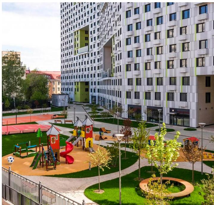
Жилой комплекс представляет собой четырехсекционный дом высотой 27 этажей. Корпус возведен по кирпично-монолитной технологии, его фасад облицован панелями белого, серого и салатового оттенков и предусматривает корзины для кондиционеров.
